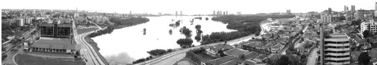
Figura 6: Lagoa da Jansen urbanizada, investimentos públicos valorizam regiões nobres, com alta visibilidade e forte carga simbólica para toda a cidade: a “modernidade” conta com a unanimidade de toda população.
