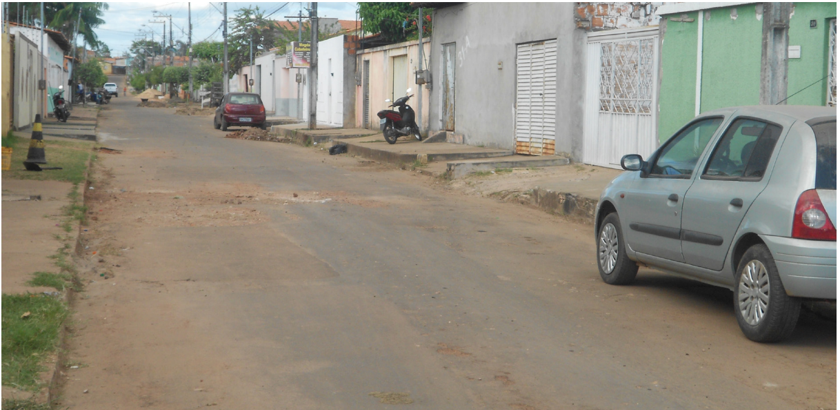
Figura 22: imagem da Rua “B”, uma das ruas do conjunto Nova Vitória I pavimentada em asfalto. Fonte: elaborado pelo autor.
