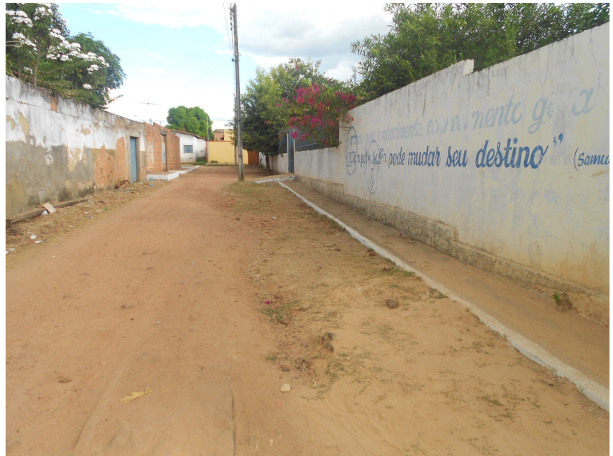
Figura 60: Via de pedestre localizada em frente a escola da rede de ensino pública do estado. Fonte: elaborada pelo autor.
