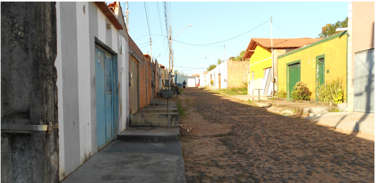
Figura 23: imagem da Rua “F”, pertencente ao conjunto Vitória II, a mesma não possui pavimentação sendo encoberta por pedras. Fonte: elaborado pelo autor.
