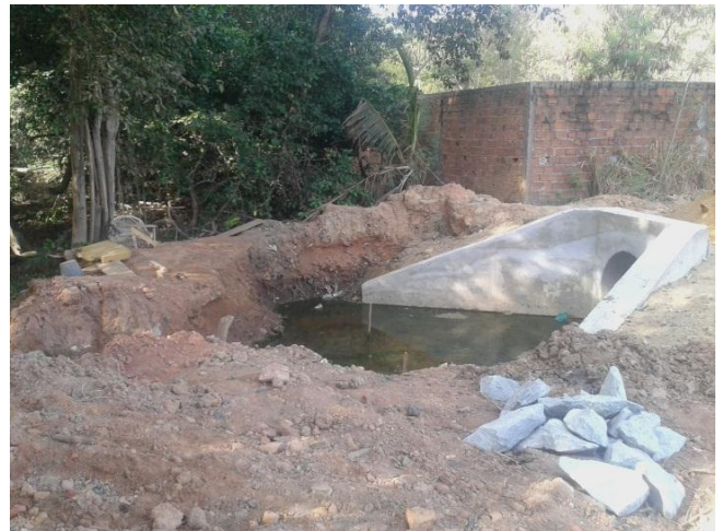
Figura 47 – Canalização desaguando no rio. Fonte: ARAUJO, 2015.
