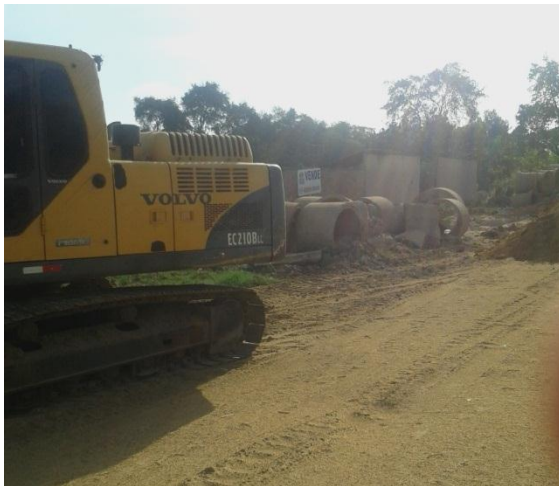
Figura 46 – Instalação de infraestrutura. Fonte: ARAUJO, 2015.
