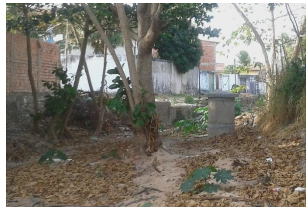
Figura 51 – Caixa de acesso a canalização do rio. Fonte: ARAUJO, 2015.
