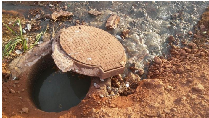
Figura 61 – Caixa de esgoto transbordando em direção ao Rio Calhau, próximo a Av. Santo Antônio, no Calhau.
