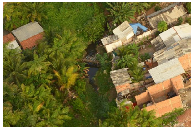
Figura 34 – Ocupação irregular em APP. Fonte: MC Engenharia Ltda, 2012.
