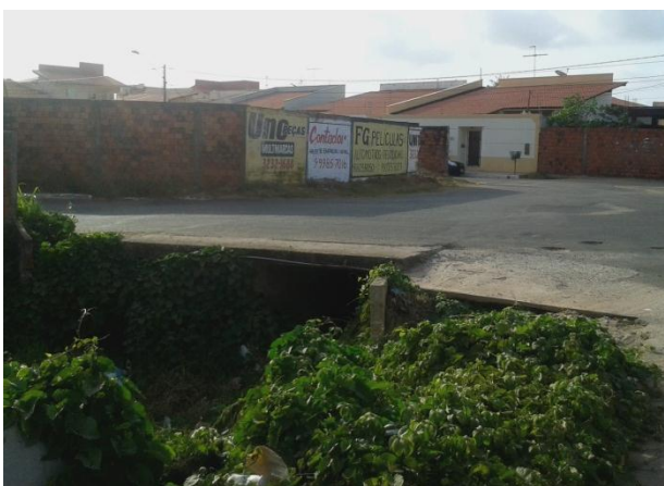
Figura 52 – Canalização sob sistema viário. Fonte: ARAUJO, 2015.
