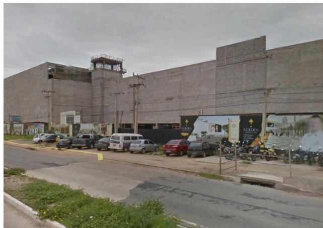
Figura 23 – Vista atual do local das inundações a partir do mesmo ponto de vista da foto anterior, na Av. Avicência, evidenciando a construção do Golden Shopping Calhau.
