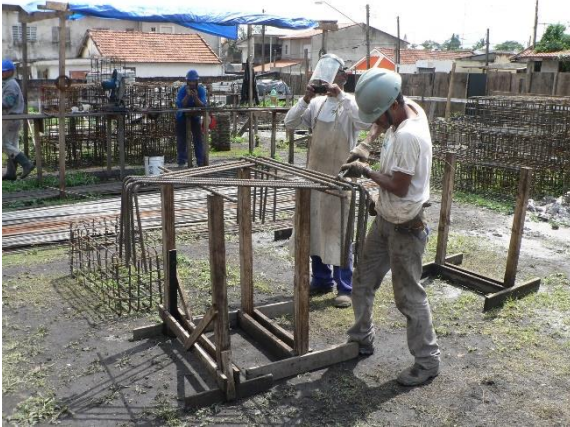
Figuras 43 –Trabalhadores contratados para a obra. Fonte: Acervo de Lenka Kužvartová.
