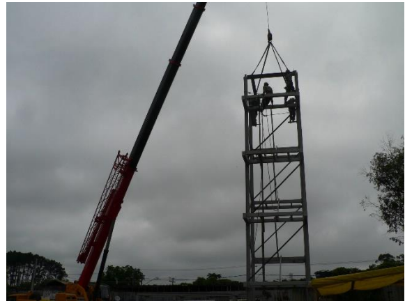
Figuras 44 – Instalação das escadas metálicas. Fonte: Acervo de Lenka Kužvartová.
