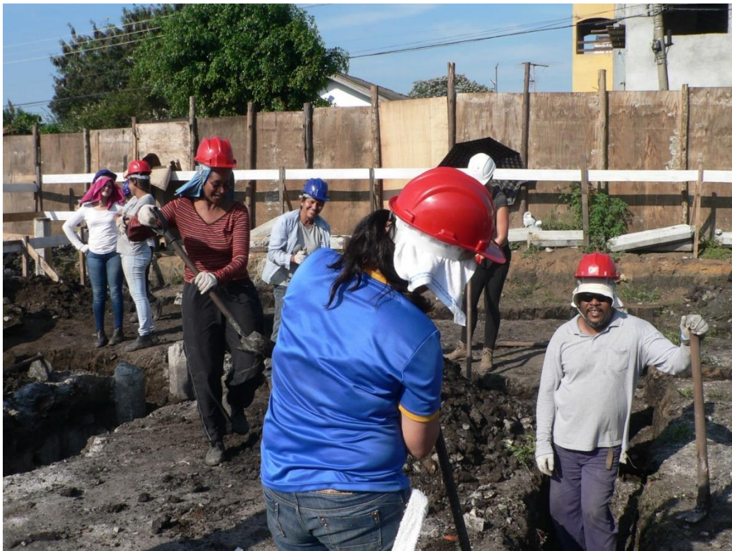
Figuras 45 – Mutirantes no canteiro de obras. Fonte: Acervo de Lenka Kužvartová.
