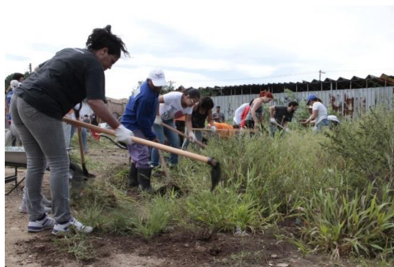
Figuras 41 – Limpeza do terreno. Fonte: Site Usina-CTAH, acesso em 21 jan. 2017.
