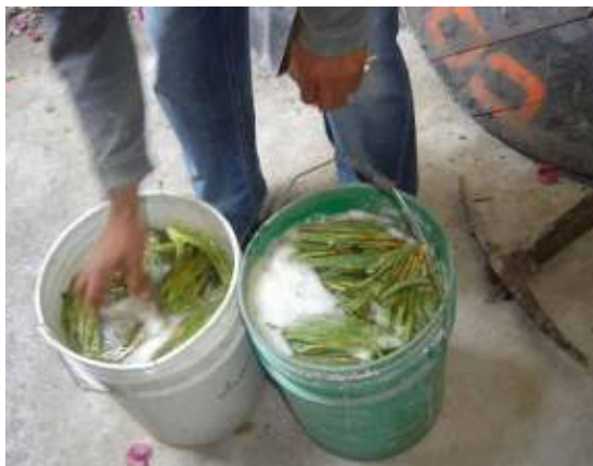
Figura 15 – Tratamento do macerado de cacto para a impermeabilização
