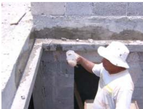
Figura 6 - Umedecimento da área de contato do BTC
