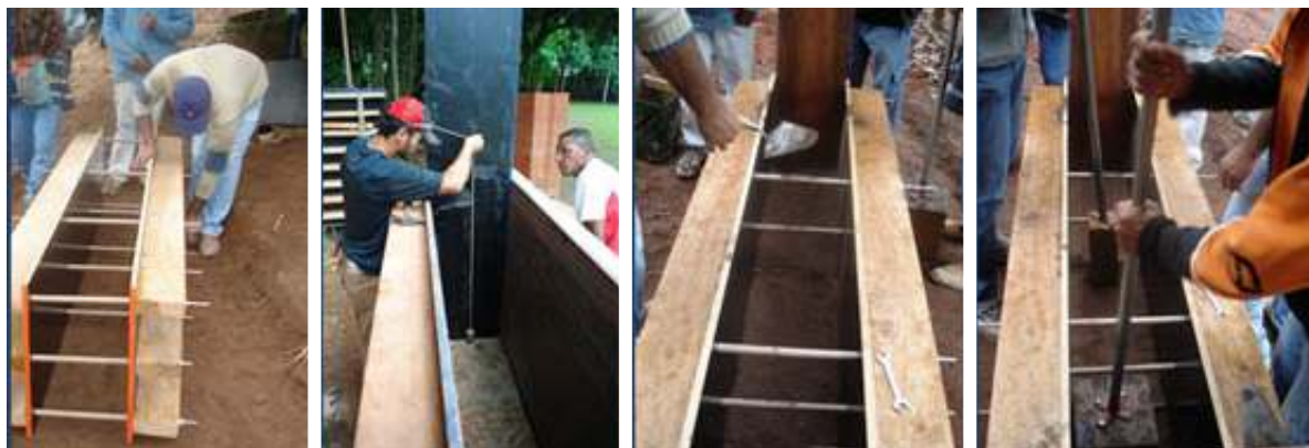
Figura 16 – Atividades de montar e aprumar a forma, espalhar a terra e compactar
