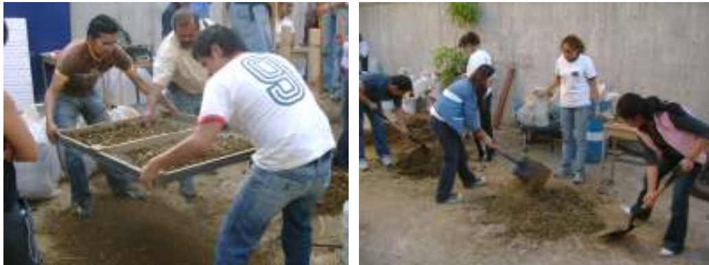
Figura 2 – Peneiramento da terra e mistura da terra com a palha
