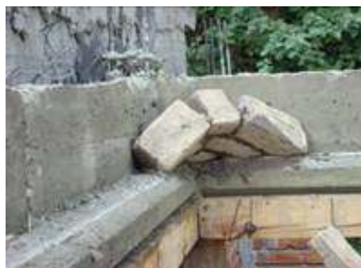
Figura 9 - Assentamento da terceira fiada, ajustada com o componente do centro
