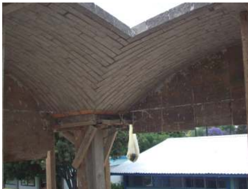
Figura 1 – Exemplo de abóbada de adobe, em execução
