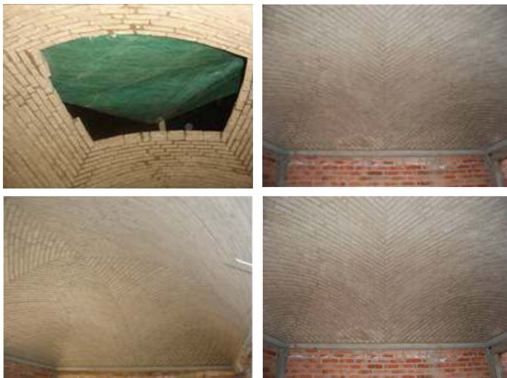
Figura 13 – Fechamento em forma de espiral e interior da abóbada concluída
