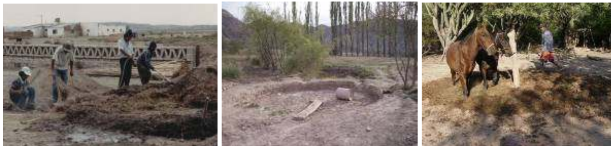
Figura 4 – Distintas formas de preparação do barro
