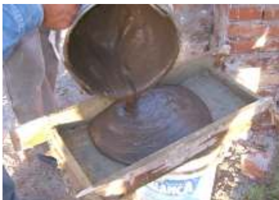
Figura 2 – Consistência da argamassa de assentamento
