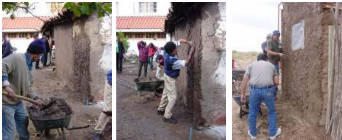
Figura 3 – Mistura do reboco inicial de barro; aplicação do reboco à mão; e, aplicação com colher de pedreiro
