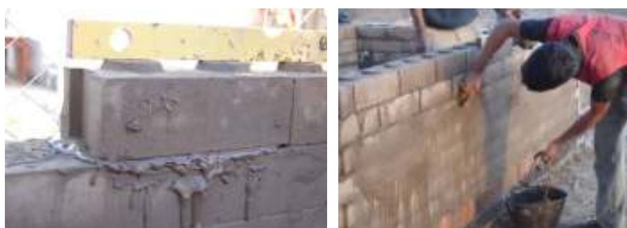
Figura 9 – Alvenaria de bloco Mattone com argamassa fluida e limpeza da superfície
