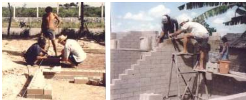
Figura 7 – Elevação de paredes com BTCs
