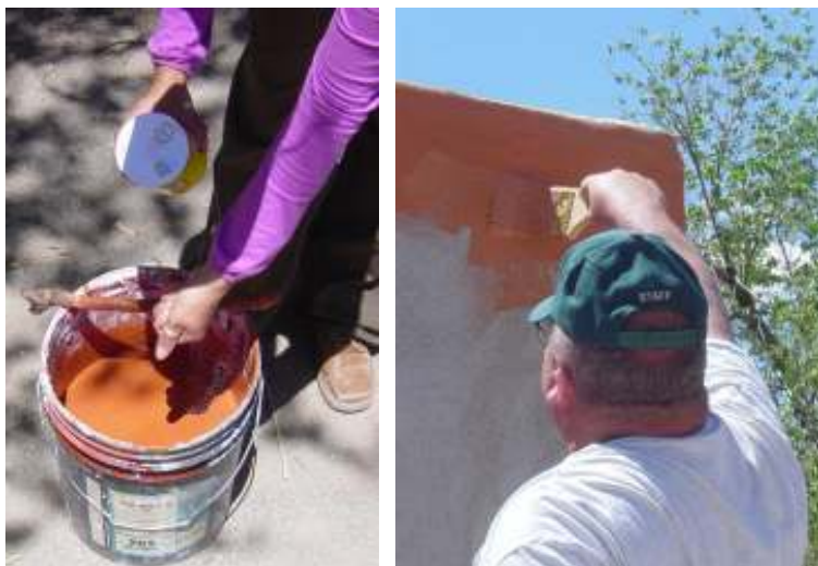
Figura 9 – Adição de fixador à cal pigmentada e aplicação da pintura na parede preparada
