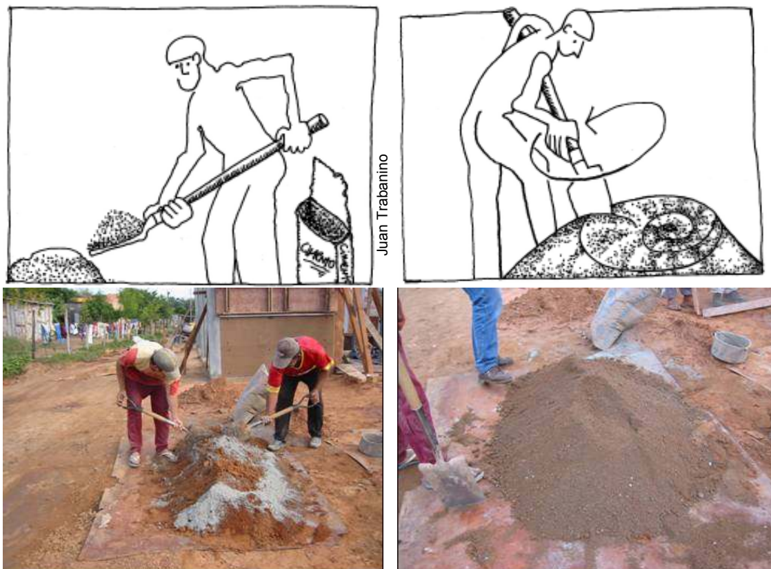
Figura 3 – Preparo da mistura de solo e cimento
