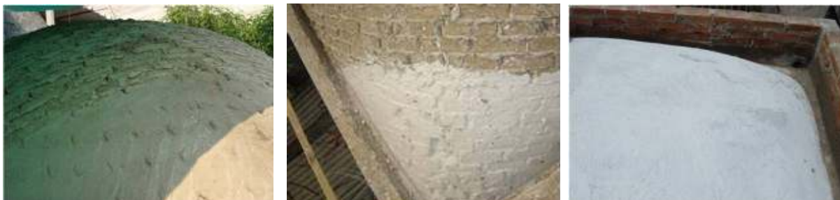
Figura 14 – Abóbada com leitada de cal e areia
