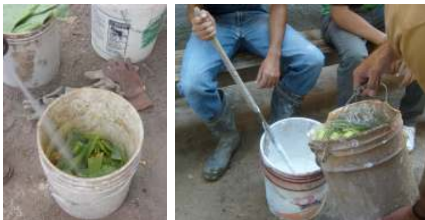
Figura 7 – Macerado de cacto. Adição e mistura da mucilagem em um recipiente cheio até a metade com pasta de cal
