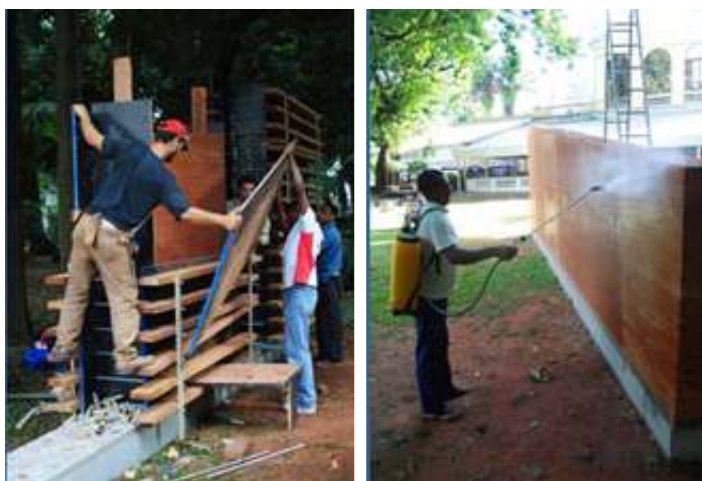
Figura 17 – Desmoldagem e cura do painel de taipa estabilizada com cimento
