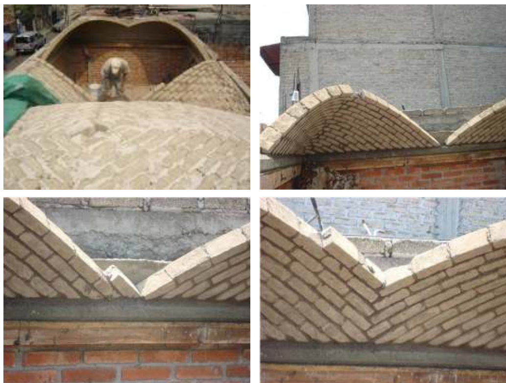
Figura 11 – Finalização de pechinas e assentamento de BTC para iniciar o fechamento da abóbada
