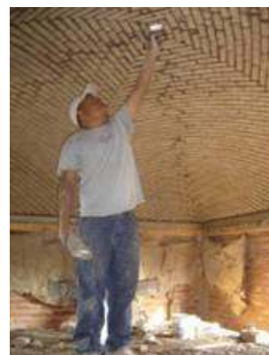
Figura 3 – Disposição e altura do andaime
