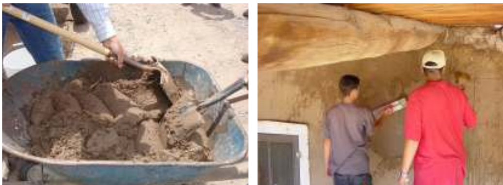
Figura 4 - Mistura para o reboco final de barro e sua aplicação com desempenadeira.
