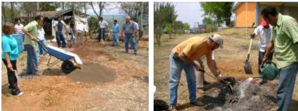
Figura 5 – Argamassa de cal e areia: adição de cal em pasta e umedecimento progressivo da mistura
