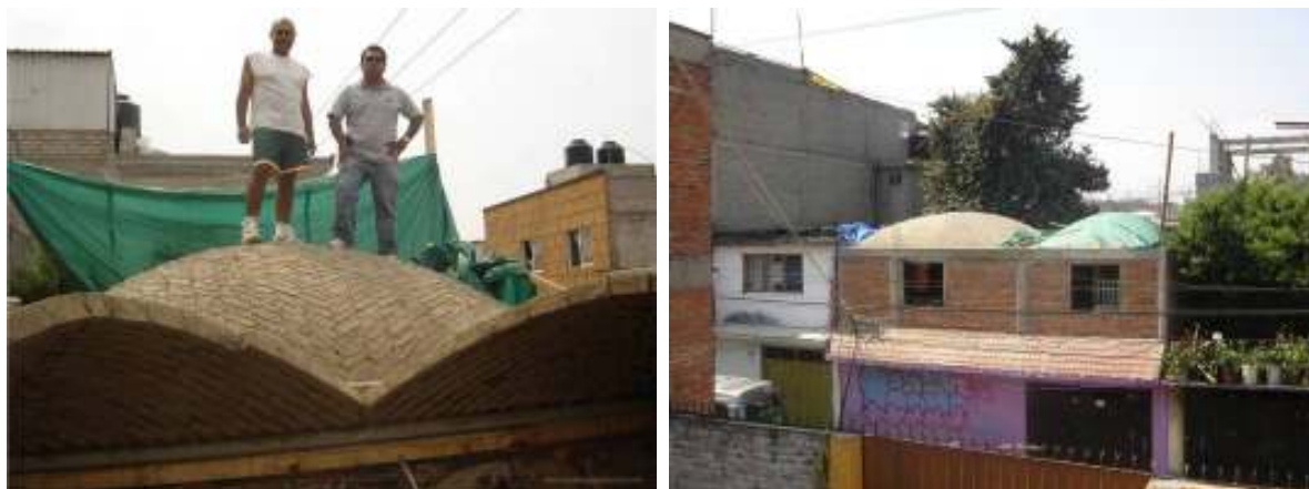
Figura 17 – Abóbadas da Casa Santo Domingo concluídas
