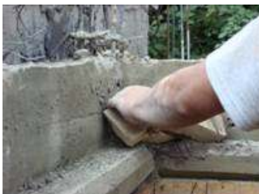
Figura 8 - Assentamento da segunda fiada de BTC
