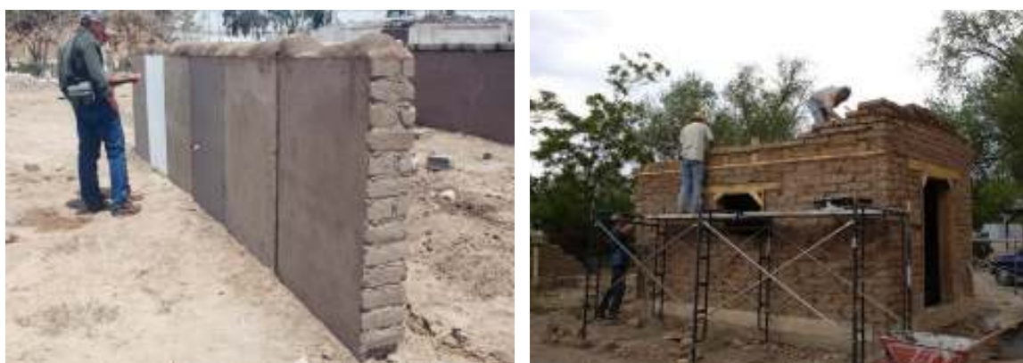
Figura 1 – Parede de trabalho para oficinas (à esquerda) e limpeza de uma parede, antes de aplicar o reboco
