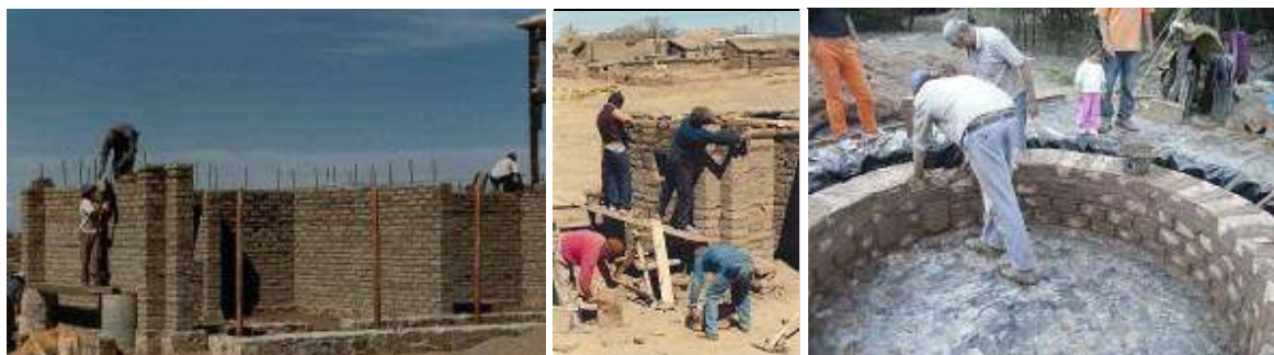
Figura 8 – Construção de paredes de adobe (Rotondaro et al, 1998; 2009)
