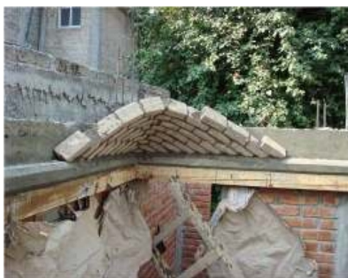
Figura 10 - Assentamento a partir da quinta fiada de BTC
