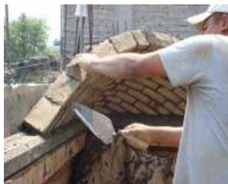
Figura 10 - Assentamento a partir da quinta fiada de BTC
