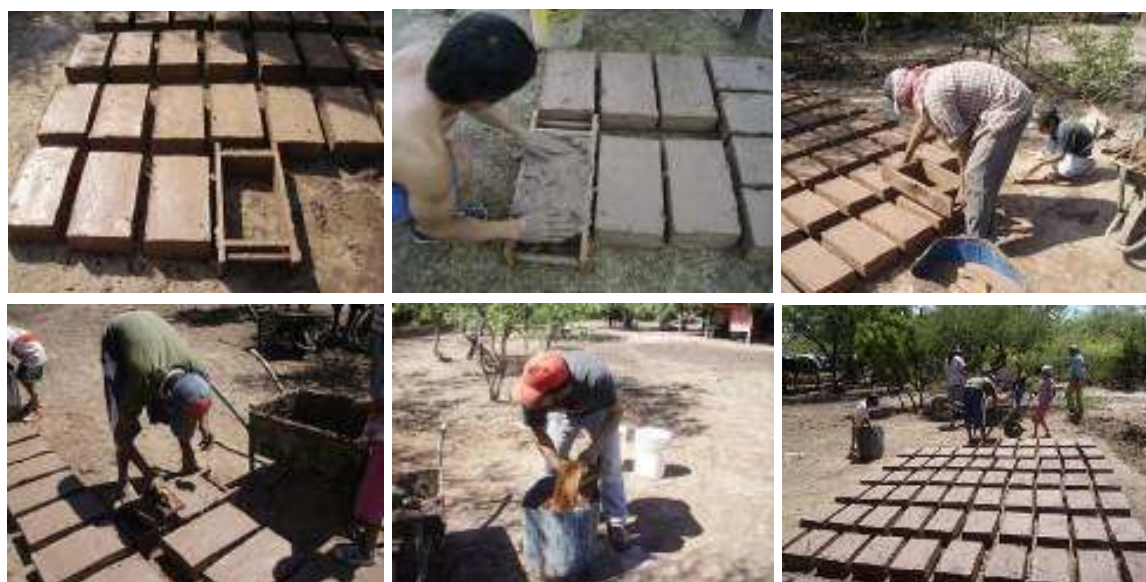
Figura 5 – Etapas de moldagem dos adobes (Rotondaro et al, 2009)
