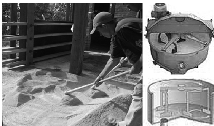
Figura 15 - Preparo da terra com adição de cal e cimento e exemplos de misturadores planetários
