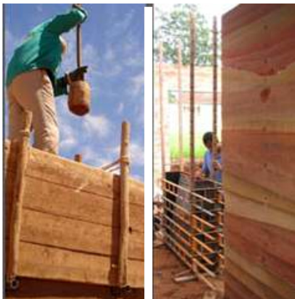
Figura 2 – Dois tipos de formas para a produção da taipa: taipal tradicional (à esquerda) e taipal metálico
