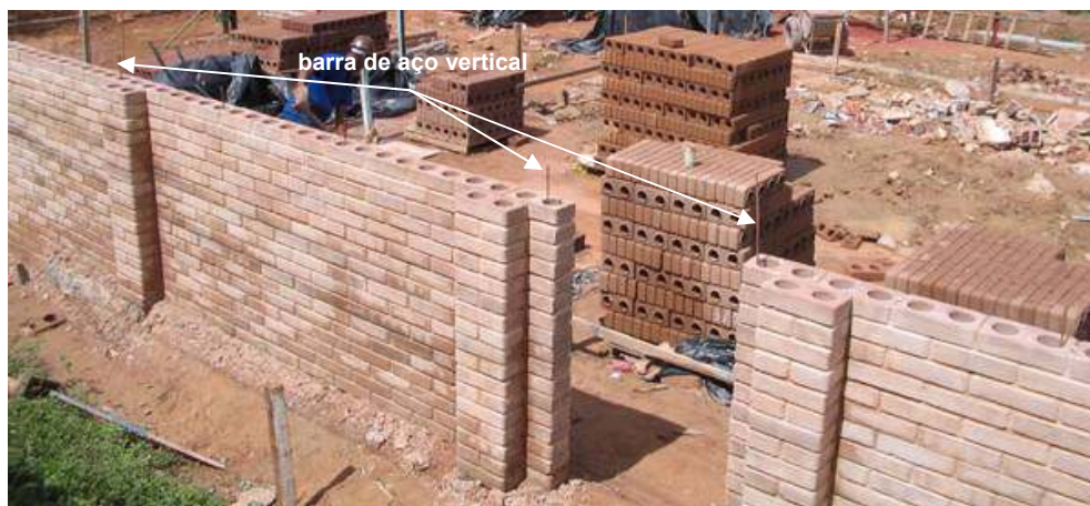
Figura 8 – Alvenaria de BTC com furos e junta de argamassa, notando-se as barras de aço verticais, para reforço da parede
