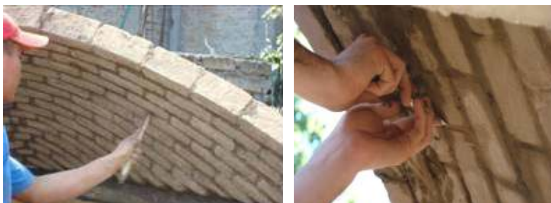
Figura 12 – Processo de limpeza das juntas de assentamento, superfície e arestas da abóbada
