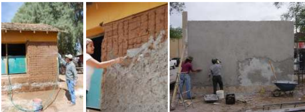
Figura 6 – Umedecimento da base; aplicação da mistura com a colher de pedreiro; e, reboco final com a mistura de cal e areia aplicada com a desempenadeira
