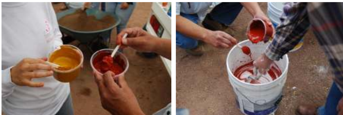
Figura 8 – Hidratação de pigmentos para a pintura e sua mistura à cal
