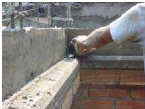
Figura 7 - Colocação da primeira metade de BTC na esquina
