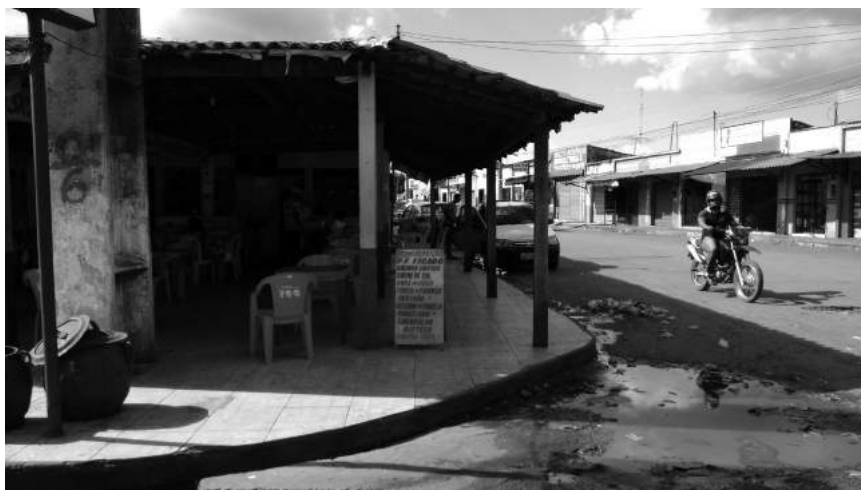
Imagens 11 e 12 - MARANHÃO. PAVIMENTAÇÃO E DRENAGEM NA CIDADE DE BACABAL
