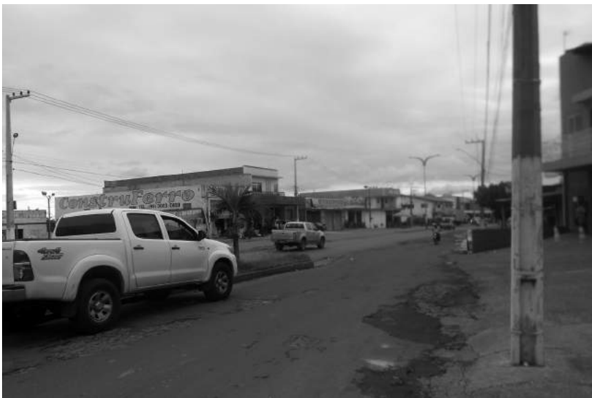
Imagens 15 e 16 - MARANHÃO. AUSÊNCIA DE MEIO-FIO E SARJETA NAS CIDADES DE PRESIDENTE DUTRA E BURITICUPU
