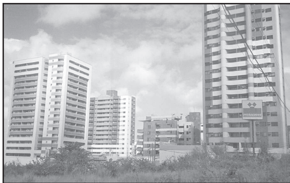
Foto 44 - Consequência da variação acelerada do gabarito no Renascença II: edificações de seis pavimentos confinadas por outras de doze e quinze andares.
