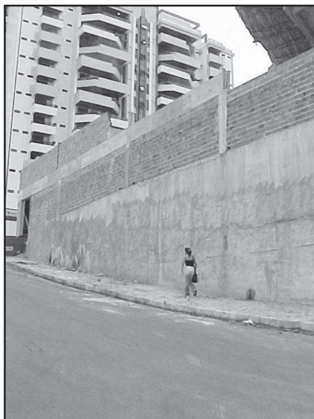
Foto 48 - Cerramento com muro cego e a escala humana em edificação residencial no Renascença II.
