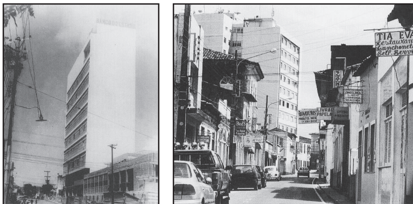
Fotos 11 e 12 - Edifício-sede do Banco do Estado do Maranhão e o edifício residencial Caiçara: modelos arquitetônicos do modernismo na cidade tradicional.
