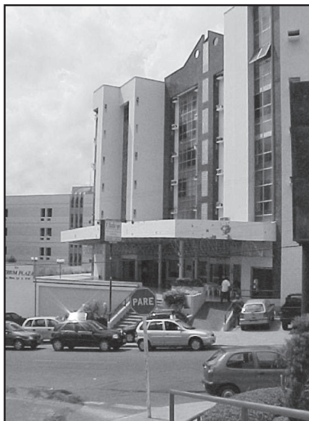
Foto 47 - Desnível e estacionamento no recuo em edificação semiprivada no Renascença II.
