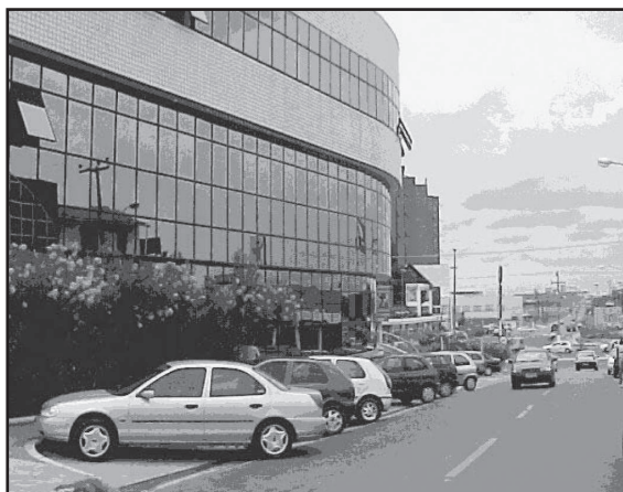
Foto 49 - Estacionamento sobre o recuo no Renascença II, com comprometimento da calçada.
