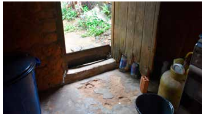
Figuras 51, 52 e 53 - Varanda com piso cimentado em casa de taipa de mão revestida, Canguçu, Aldeias Altas, cerâmica esmaltada em parte da sala de moradia, São Miguel dos Correias, Cajari, e desagregação do piso cimentado em casa de taipa de mão no Parque Almiro Paiva, Bacabal.
