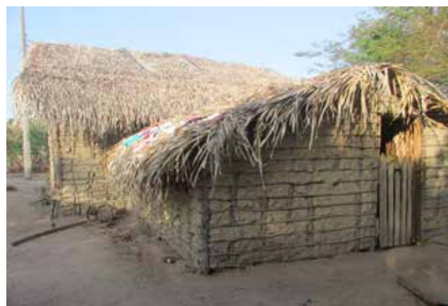
Figuras 9, 10 e 11 - Soluções de coberturas: telha cerâmica no corpo principal e palha na meia-água; empena lateral em taipa de mão e cobertura de palha; puxado com águas do telhado de palha perpendicular ao corpo principal da moradia.
