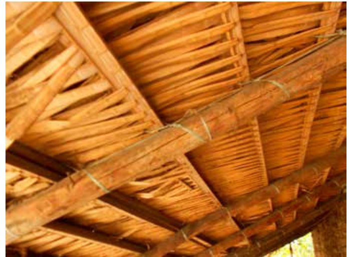
Figura 17 - Vista de ambiente interno do entramado de madeira coberto com telhas cerâmicas pronta para receber tapagem com barro, Maracá, Pindaré Mirim.
