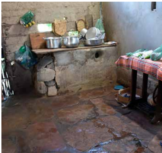
Figura 49 e 50 - Escada interna com degraus de adobe em moradia do mesmo material, Jenipapo dos Vieiras, e pedras de cantaria no piso da cozinha, Faveira, Brejo.
