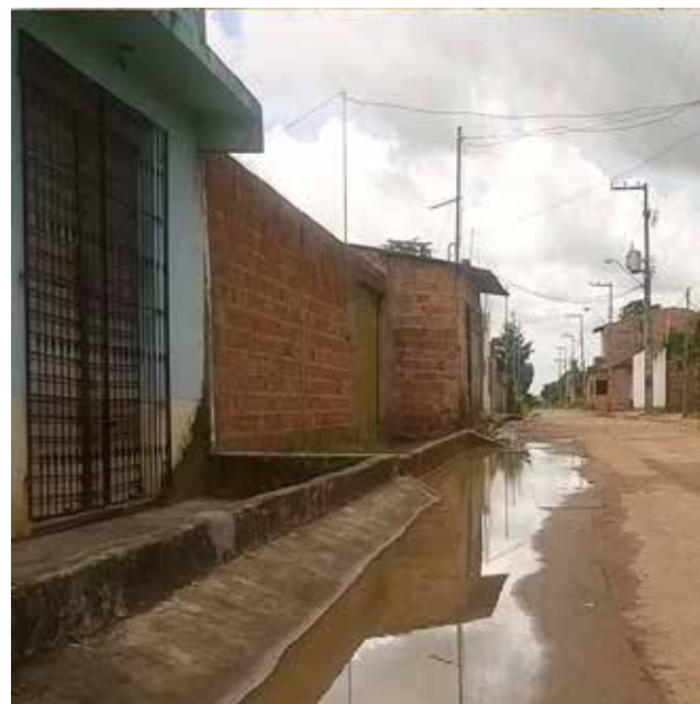
Figura 1 e 2 - Precariedades no serviço de coleta de resíduos sólidos e na drenagem pluvial.
