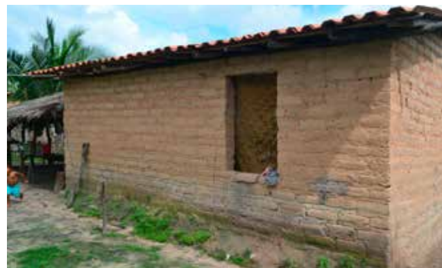
Figura 35 - Esquema de assentamento da parede de adobe sobre fiada de adobe tição como base. Figuras 36 e 37 - Adobe tição sobre alicerce de pedra aparente e calçada de barro, Morro do Chupé, e sem tição ou baldrame, Barracão, São Raimundo das Mangabeiras.
