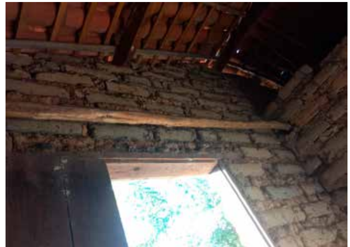
Figura 62 - Redes armadas nos esteios de madeira de dormitório de moradia de taipa de mão, Aldeia Tabocal, Terra Indígena Rio Pindaré. Figuras 63, 64 e 65 - Escápulas de madeira e de ferro em paredes de adobe rebocado, Pastos Bons e Faveira, e travessão de madeira para redes em casa de adobe, São Raimundo, Brejo.
