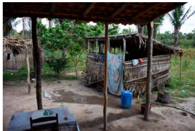
Figura 69 - Banheiro completo com piso e paredes em cerâmica esmaltada em moradia de adobe revestida, São Raimundo, Brejo. Figura 70 e 71 - Casas de banho em taipa de mão em Oitua, Alcântara, e palha de babaçu, Faveira, Brejo.
