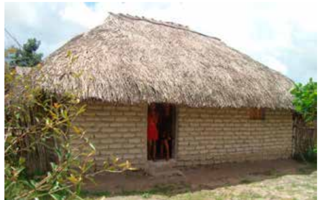
Figura 11 - Adobe revestido e cobertura de telhas cerâmicas
