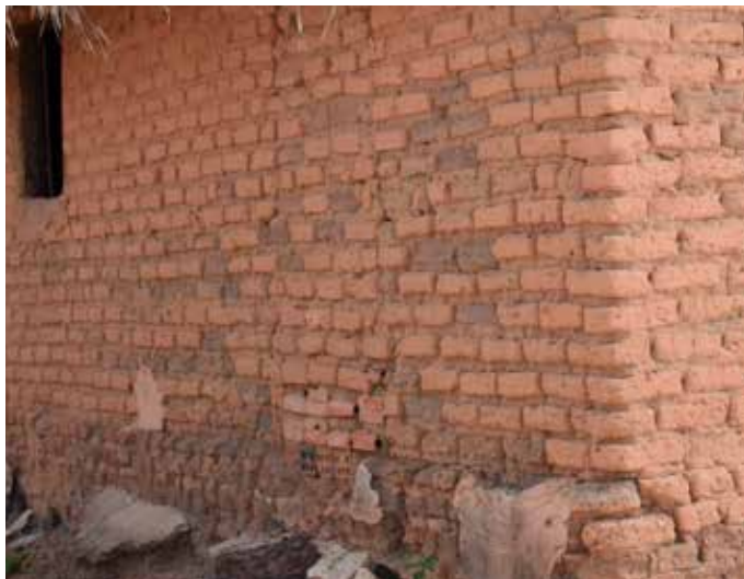
Figura 35 - Esquema de assentamento da parede de adobe sobre fiada de adobe tição como base. Figuras 36 e 37 - Adobe tição sobre alicerce de pedra aparente e calçada de barro, Morro do Chupé, e sem tição ou baldrame, Barracão, São Raimundo das Mangabeiras.
