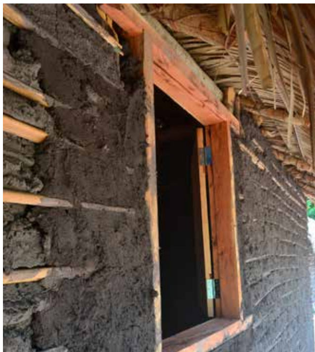
Figura 21 - Meaçaba utilizada como folha de janela em casa de taipa de mão, Mangueirão, Cajari.
