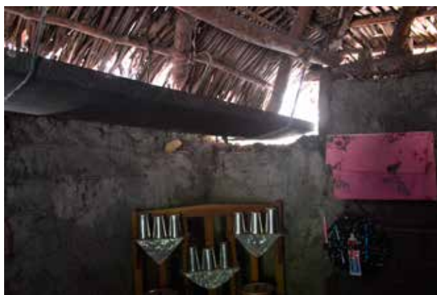
Figuras 4 e 5 - Coberturas de palha de babaçu e telha cerâmica com madeirame apoiado nas paredes de moradias de taipa de mão, Barro Vermelho, Chapadinha, Canguçu, Aldeias Altas. Figura 6 - Calha de zinco em telhado de palha de pindova em moradia de taipa de mão de canto dobrado, Taboca, Aldeias Altas.
