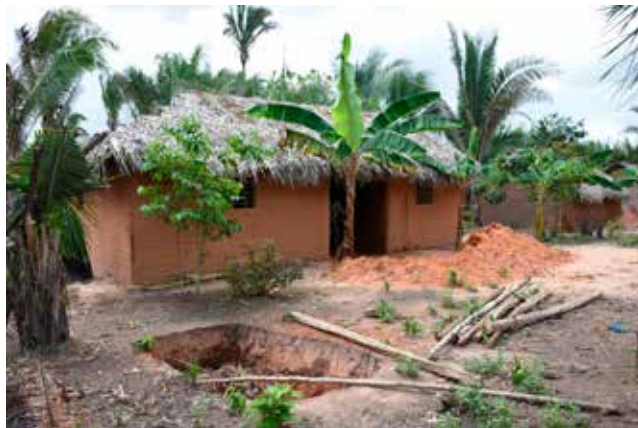
Figura 10 - Gaiola de armação para casa de taipa de mão com cobertura de telha cerâmica, portas e janelas de almofadas reutilizadas, Núcleo G1, Zé Doca.
