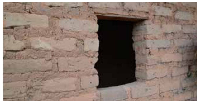
Figura 38 - Alvenaria de tijolos de adobe parcialmente rebocada com cinta superior de concreto, Pequizeiro, Belágua.
