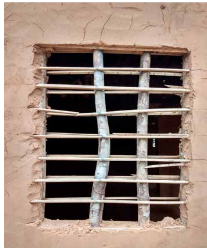
Figura 22 - Caixa e folha de janela em madeira de casa de taipa de mão em processo final de tapagem, Taboca, Aldeias Altas.
