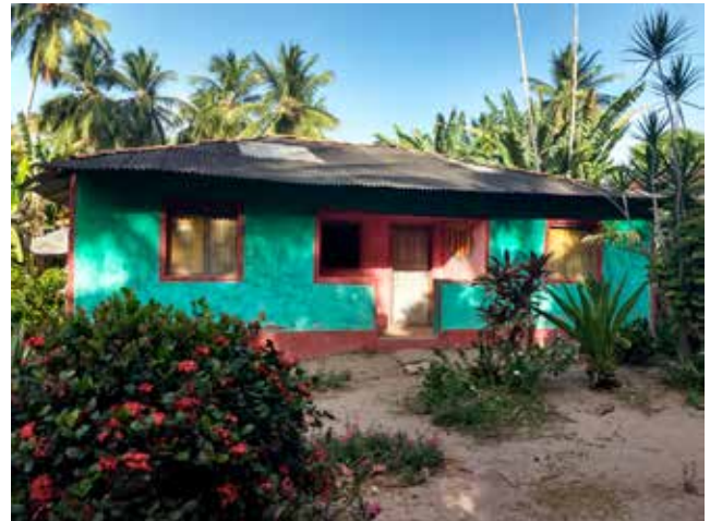
Figura 54 - Reboco de fachada principal com uso de cacos de telha cerâmica em moradia de adobe, Barracão, São Raimundo das Mangabeiras.
