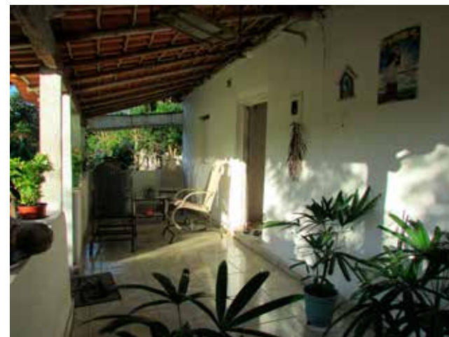
Figura 47 - Moradia de adobe revestido com piso da sala em cacos de cerâmica de diferentes padrões e tamanhos, Canelatiua, Alcântara.
