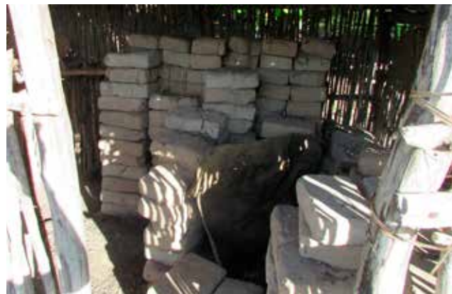
Figura 29 - Demolição de casa de adobe com aproveitamento de parte dos tijolos em Pequizeiro, Belágua. Figuras 30 e 31 -Tijolos de adobe estocados em anexos de moradias, Pastos Bons e Belágua.
