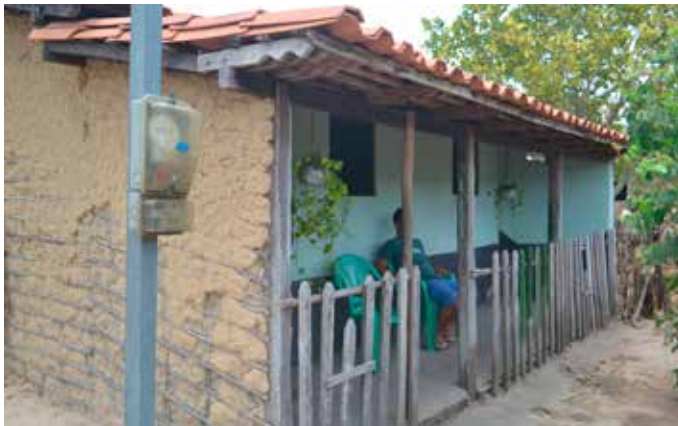
Figura 24 - Folha de janela de abrir em madeira lavrada em casa de taipa de mão, Gameleira, Cajari. Figura 25, 26, 27 e 28 - Varanda frontal fechada com varas de madeira, guarda-corpo de varanda, folha de porta e cancela executadas com ripas de madeira em casas de taipa de mão, São Miguel dos Correias, Cajari.
